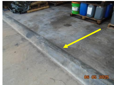
ภาพที่ 2-60 คันกันป้องกันการรั่วไหลของน้ำมันบริเวณอาคาร สำหรับจัดเก็บน้ำมัน
