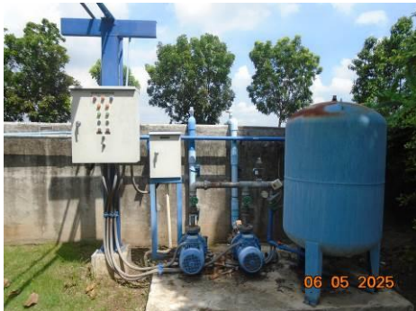
ภาพที่ 2-57 ระบบปั้มน้ำจากบ่อกักน้ำทิ้งมารดน้ำต้นไม้ ในพื้นที่โรงไฟฟ้า
